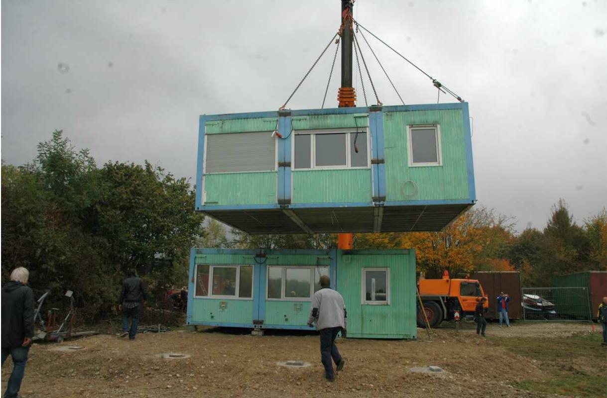
Millimetergenau wird die Gruppe auf das „Erdgeschoß“ aufgesetzt.
