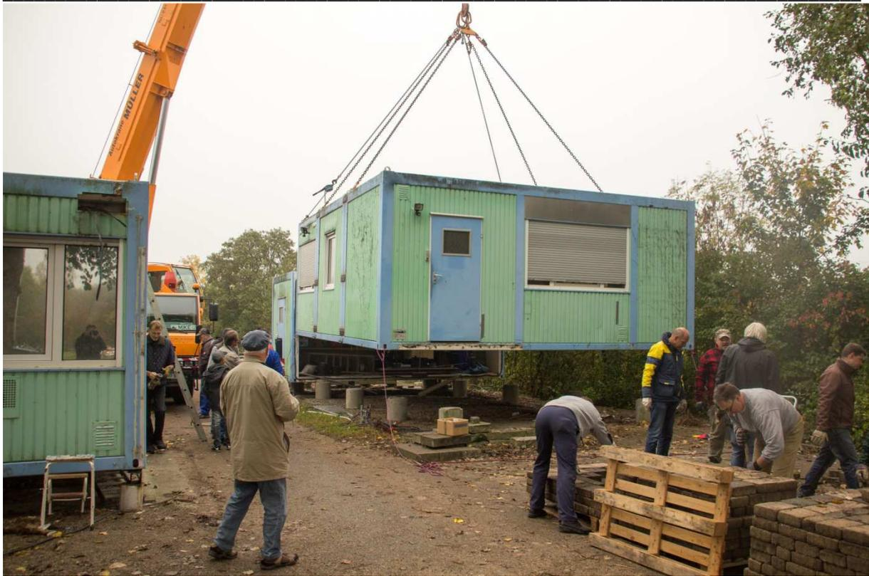
Dann senkt der Autokran die Containerbehälter auf einen Tieflader, wo sie für den kurzen Transportweg mit breiten Spanngurten gesichert werden.
